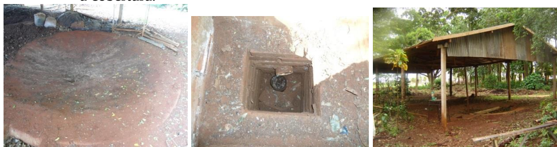
Figura 1 - Composteira côncava, destacando a perfuração que sai o cano para o reservatório e a cobertura.
