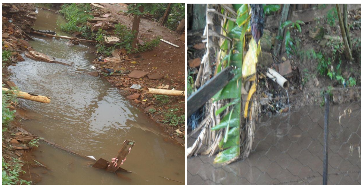
Figura 4: Esgoto ligado diretamente no Arroio Ouro Verde.
