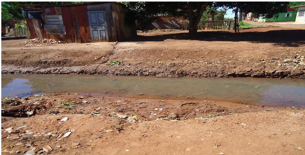
Figura 7: Assoreamento do Arroio Ouro Verde.
