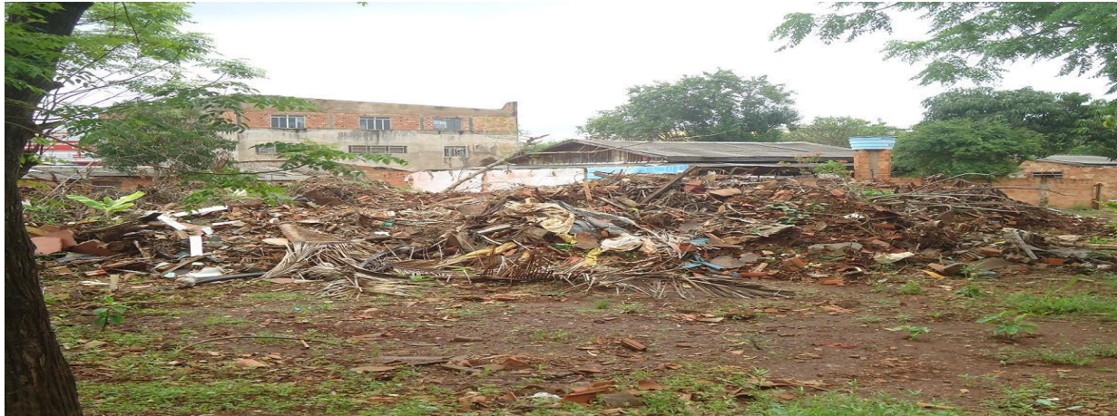
Figura 6: Resto de construção civil jogado na bacia Arroio Ouro Verde
